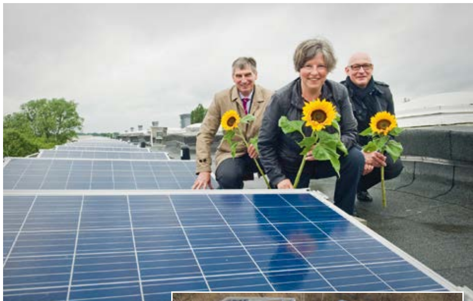
Im Pankower Pankeviertel wurden auf Gebäuden der GESOBAU AG eine der größten Mieterstrom-Photovoltaikanlagen Deutschlands errichtet
